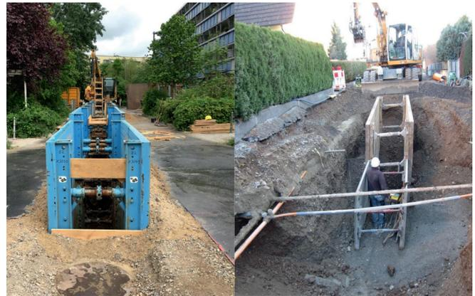
Entspricht die Bauausführung den allgemein anerkannten Regeln der Technik? Ein nicht fachgerecht eingestellter Verbau (r.) hat Einfluss auf das Gleichgewicht des umliegenden Erdreiches und kann zum Beispiel zu Setzungen führen, welche die angrenzende Bebauung erheblich schädigen kann.
