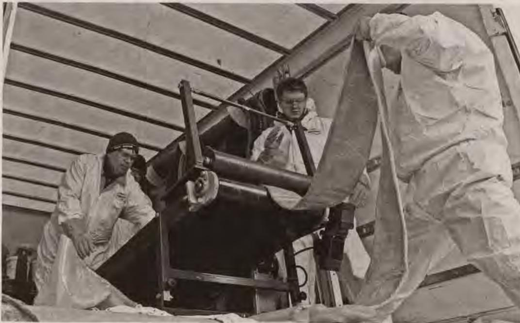
Präparieren des Brawoliner auf der Prüfungsbaustelle in Würzburg.
