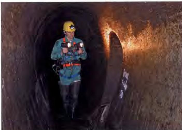
Die Untersuchung von begehbaren Großprofilen mit unmittelbarer Schnittstelle des Inspektionsdatenflusses an EDV-gestützte Kanaldatenbanken ist eine Spezialität von ISAS.
