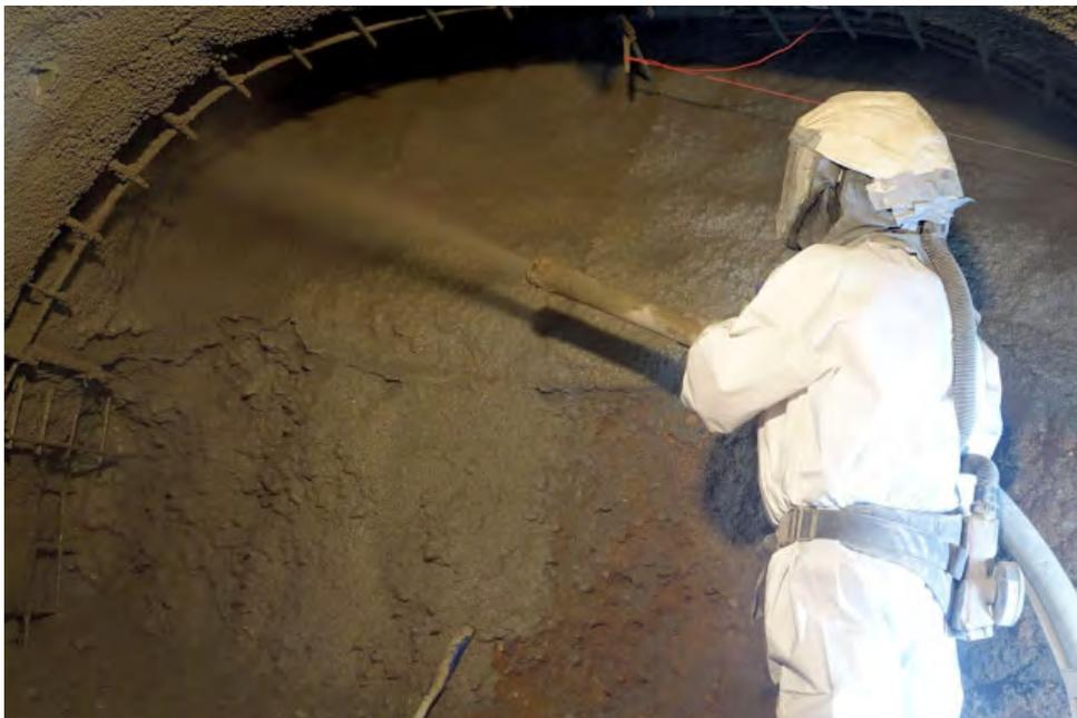
Das Auftragen des Spritzbetons erfolgt direkt an der Ortsbrust zur Sicherung des Stollens.
