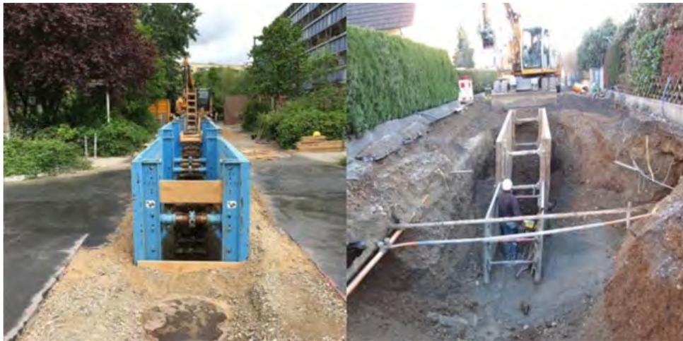
Entspricht die Bauausführung den allgemein anerkannten Regeln der Technik? Ein nicht fachgerecht eingestellter Verbau (r.) hat Einfluss auf das Gleichgewicht des umliegenden Erdreiches und kann zum Beispiel zu Setzungen führen, welche die angrenzende Bebauung erheblich schädigen kann. | Fotos und Abbildung: Güteschutz Kanalbau
