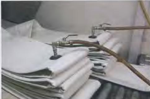
**Bild 3:** Aufbringen des Vakuums vor der Tränkung der Schlauchliner mit dem Härz
