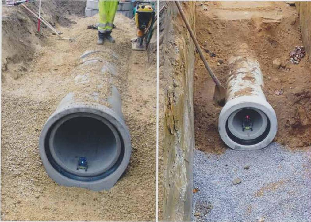
Abb. 4 – Fachgerecht (links): einheitliches Material für die Bettung; unsachgemäß (rechts): unterschiedliche Materialien für untere und obere Bettungsschicht
