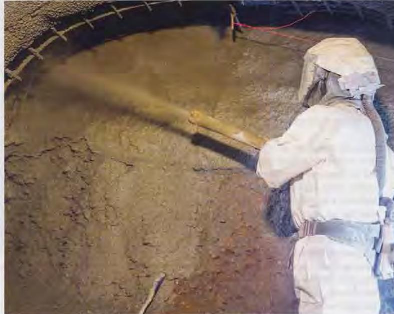
Das Auftragen des Spritzbetons erfolgt direkt an der Ortsbrust zur Sicherung des Stollens. | Fotos: Güteschutz Kanalbau
