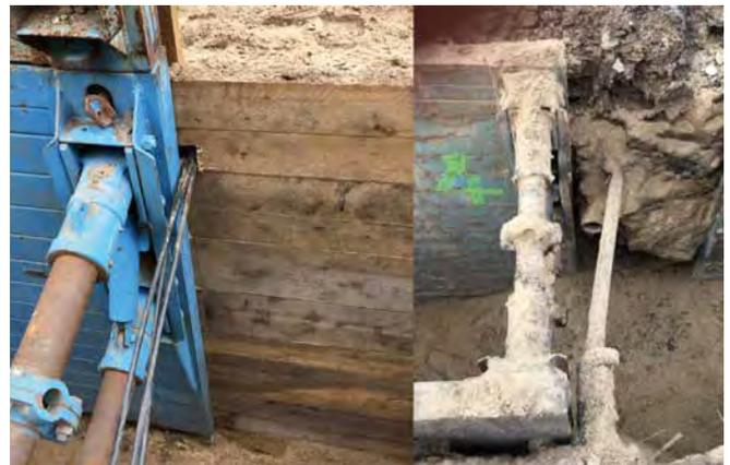
Abb. 3: Fachgerecht (l.) und unsachgemäß (r.): Aussparungen im Verbausystem sind grundsätzlich nicht zulässig – die Verkleidung muss vollflächig sein.
