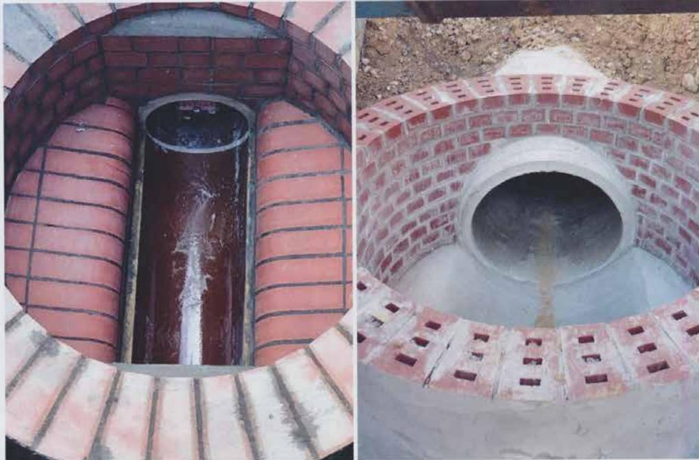
Abb. 5 – Links: Fachgerecht hergestelltes Schachtunterteil; rechts: Verwendung unzulässiger Klinker
