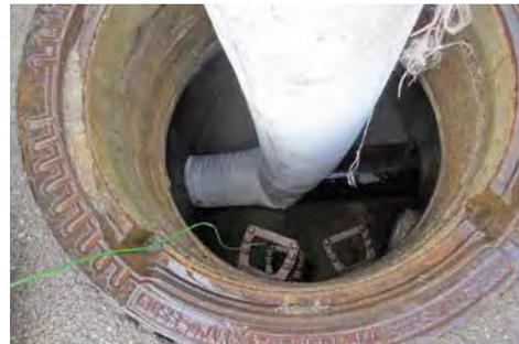
Abb. 2: Einbringen des Schlauches über den Schacht in die Haltung. Das grüne Kabel dient zur Übertragung der Temperaturwerte an das Datenaufzeichnungsgerät.
