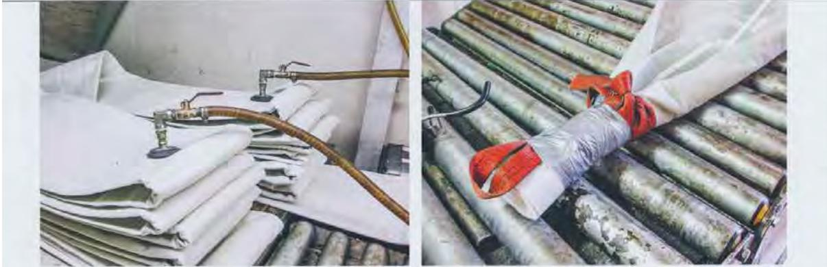
Links: Aufbringen des Vakuums vor der Tränkung der Schlauchliner mit dem Harz. Rechts: Wasserdicht zusammengebundenes Ende des Schlauchliners vor Abschluss der Inversion.
