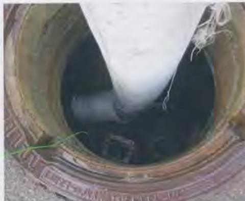
**Bild 2:** Einbringen des Schlauches über den Schacht in die Haltung. Das grüne Kabel dient zur Übertragung der Temperaturwerte an das Datenaufzeichnungsgerät.
