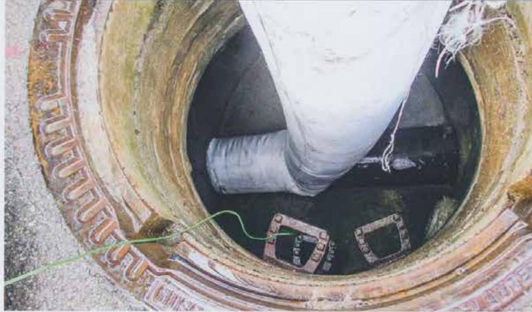
Einbringen des Schlauches über den Schacht in die Haltung. Das grüne Kabel dient zur Übertragung der Temperaturwerte an das Datenaufzeichnungsgerät.
