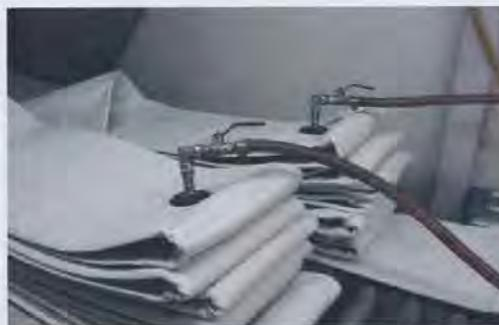
Aufbringen des Vakuums vor der Tränkung der Schlauchliner mit dem Harz. Foto: Güteschutz Kanalbau
