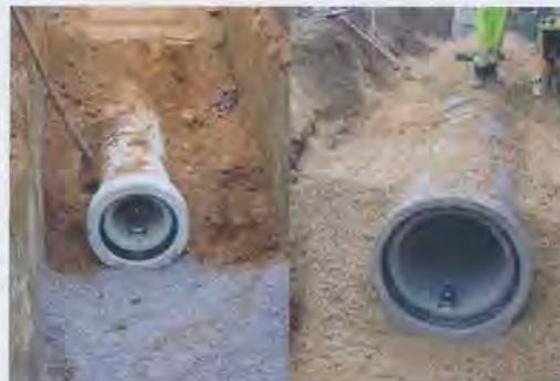
*Unsachgemäß bzw. fachgerecht: Unterschiedliche Materialien für untere und obere Bettungsschicht (l.). Einheitliches Material für die Bettung (r.).*
