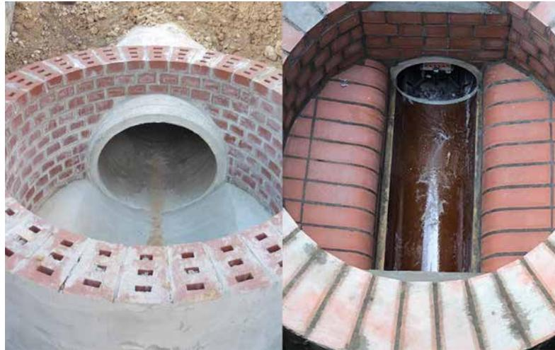
Abb. 3: Unsachgemäß bzw. fachgerecht: Verwendung unzulässiger Klinker (l.). Fachgerecht hergestelltes Schachtunterteil (r.).
