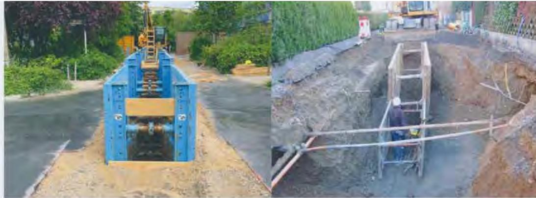
Entspricht die Bauausführung den allgemein anerkannten Regeln der Technik? Ein nicht fachgerecht eingestellter Verbau (r.) hat Einfluss auf das Gleichgewicht des umliegenden Erdreiches und kann zum Beispiel zu Setzungen führen, welche die angrenzende Bebauung erheblich schädigen kann. | Fotos und Abbildung: Güteschutz Kanalbau
