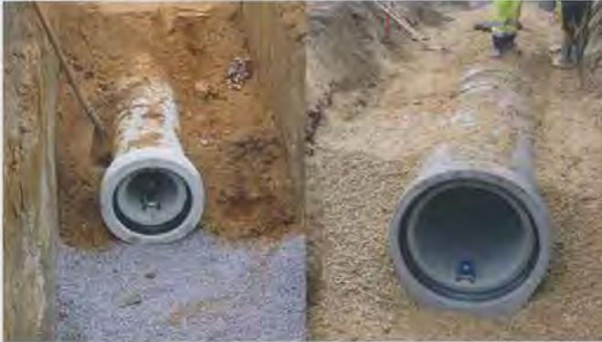
**Bild 2:** Unsachgemäß bzw. fachgerecht; Unterschiedliche Materialien für untere und obere Bettungsschicht (l.). Einheitliches Material für die Bettung (r.)
