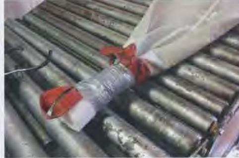
**Bild 4:** Vor Abschluss der Inversion wird das Ende des Schlauchliners wasserdicht zusammengebunden
