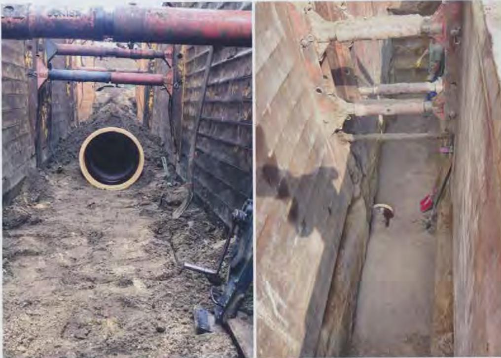
**Abb. 3** – Die extreme Abweichung zwischen Rohr- und Verbauachse macht eine fachgerechte Herstellung der Bettung und der Zwickelverdichtung nicht möglich (rechts); fachgerechter Einbau links.
