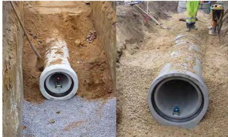
Abb. 2: Unsachgemäß bzw. fachgerecht: Unterschiedliche Materialien für untere und obere Bettungsschicht (l.). Einheitliches Material für die Bettung (r.).
