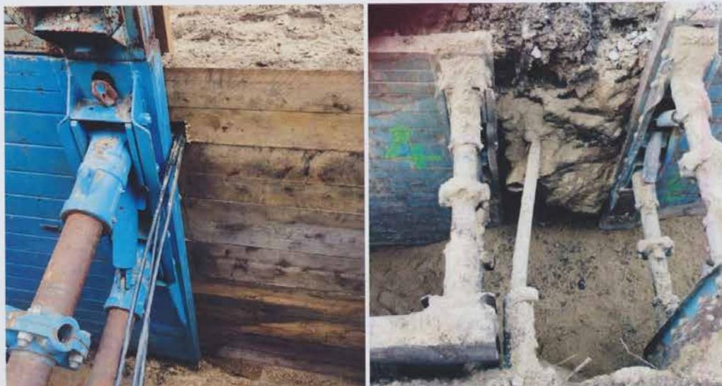
Abb. 6 – Fachgerecht (links) vs. unsachgemäß (rechts): Aussparungen im Verbausystem sind grundsätzlich nicht zulässig – die Verkleidung muss vollflächig sein.
