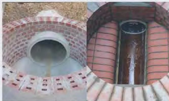
**Bild 3:** Unsachgemäß bzw. fachgerecht; Verwendung unzulässiger Klinker (l.), fachgerecht hergestelltes Schachtunterteil (r.)
