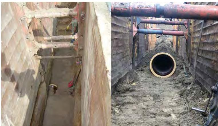
Abb. 1: Unsachgemäß bzw. fachgerecht: Die extreme Abweichung zwischen Rohr- und Verbauachse macht eine fachgerechte Herstellung der Bettung und der Zwickelverdichtung nicht möglich (l.). Einbau des Rohres mit beidseitig gleichem Arbeitsraum gemäß Regelwerk (r.).
