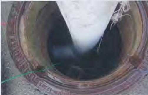
Einbringen des Schlauches über den Schacht in die Haltung. Das grüne Kabel dient zur Übertragung der Temperaturwerte an das Datenaufzeichnungsgerät. Foto: Güteschutz Kanalbau
