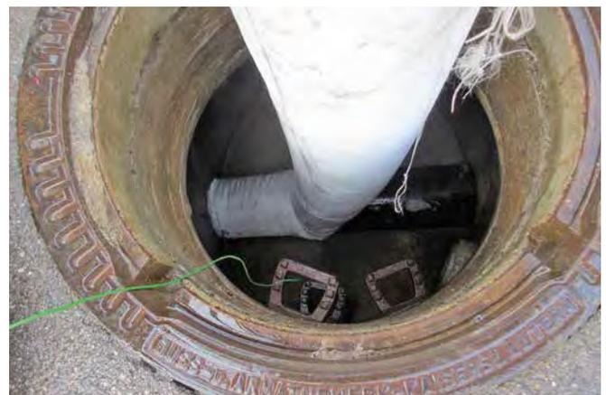
Abb. 2: Einbringen des Schlauches über den Schacht in die Hal tung. Das grüne Kabel dient zur Übertragung der Temperaturwerte an das Datenaufzeichnungsgerät.
