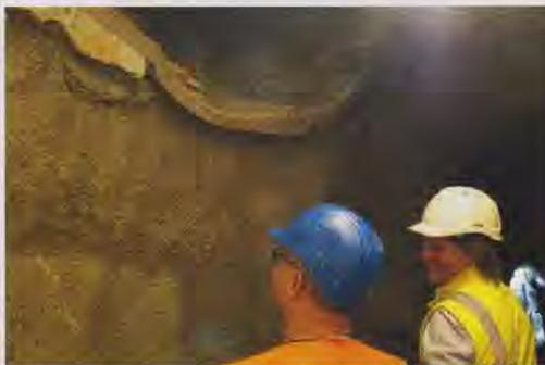
**Bild 1:** Die Überreste der alten Trinkwasserleitung sind noch deutlich zu erkennen. Heiko Nytsch (l.) und Dipl.-Ing. Jens Uhlig sind sich einig: Hier wäre jedes andere grabenlose Verfahren als der bergmännische Stollenvortrieb gescheitert
