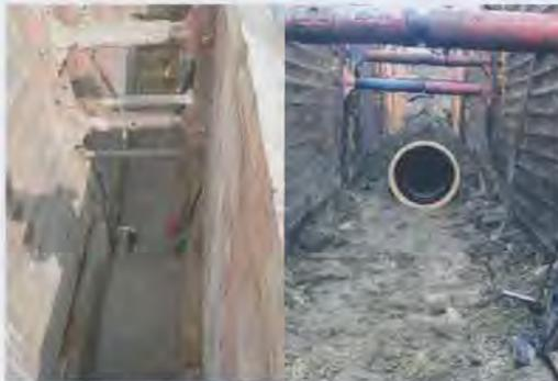
*Unsachgemäß bzw. fachgerecht: Die extreme Abweichung zwischen Rohr- und Verbauachse macht eine fachgerechte Herstellung der Bettung und der Zwickelverdichtung nicht möglich (l.). Einbau des Rohres mit beidseitig gleichem Arbeitsraum gemäß Abb.: Güteschutz Kanalbau*
