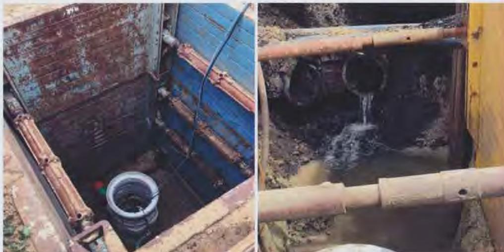
Abb. 2 – Fachgerecht (links) vs. unsachgemäß (rechts): Keine Bagatelle – wer unbefugt ein Gewässer verunreinigt oder sonst dessen Eigenschaften nachteilig verändert, kommt mit dem Gesetz in Konflikt.
