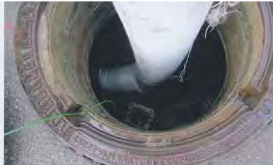
Einbringen des Schlauches über den Schacht in die Haltung. Das grüne Kabel dient zur Übertragung der Temperaturwerte an das Datenaufzeichnungsgerät.
