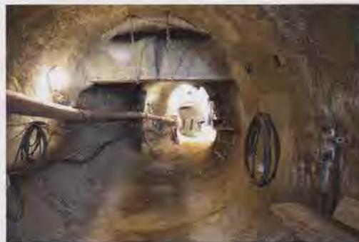
**Bild 2:** Der Stollen wird laut Planungen in gekrümmter Linienführung hergestellt. Eine kreuzende Abwasserleitung wird während der Baumaßnahme temporär abgefangen und später an den fertigen Kanal angeschlossen
