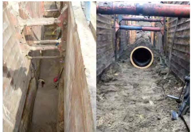
Abb. 1: Unsachgemäß bzw. fachgerecht: Die extreme Abweichung zwischen Rohr- und Verbauachse macht eine fachgerechte Herstellung der Bettung und der Zwickelverdichtung nicht möglich (l.). Einbau des Rohres mit beidseitig gleichem Arbeitsraum gemäß Regelwerk (r.).
