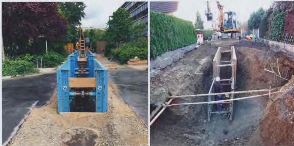
**Abb. 1** – Ein nicht fachgerecht eingestellter Verbau (rechts) hat Einfluss auf das Gleichgewicht des umliegenden Erdreiches und kann z. B. zu Setzungen führen, die wiederum die angrenzende Bebauung erheblich schädigen kann; links zu sehen ein fachgerecht eingestellter Verbau.
