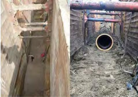
Unsachgemäß bzw. fachgerecht: Die extreme Abweichung zwischen Rohr- und Verbauachse macht eine fachgerechte Herstellung der Bettung und der Zwickelverdichtung nicht möglich (l.). Einbau des Rohres mit beidseitig gleichem Arbeitsraum gemäß Regelwerk (r.).
