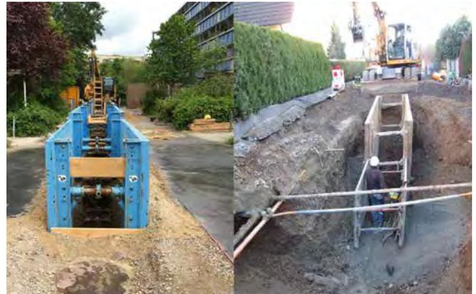
Entspricht die Bauausführung den allgemein anerkannten Regeln der Technik? Ein nicht fachgerecht eingestellter Verbau (r.) hat Einfluss auf das Gleichgewicht des umliegenden Erdreiches und kann zum Beispiel zu Setzungen führen, welche die angrenzende Bebauung erheblich schädigen kann.
