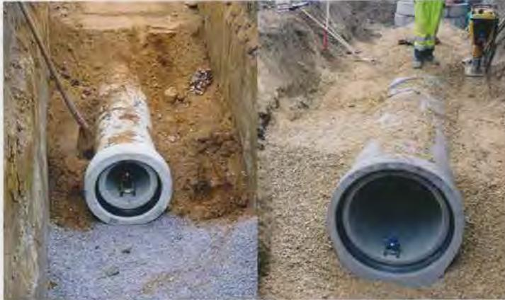
Abb. 2: Unsachgemäß bzw. fachgerecht; Unterschiedliche Materialien für die untere und obere Bettungsschicht (links) – Einheitliches Material für die Bettung (rechts)
