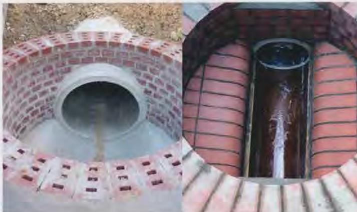
Abb. 3: Unsachgemäß bzw. fachgerecht; Verwendung unzulässiger Klinker (links) – Fachgerecht hergestelltes Schachtunterteil (rechts)
