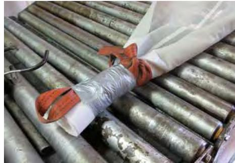
Abb. 4: Vor Abschluss der Inversion wird das Ende des Schlauchliners wasserdicht zusammengebunden.
