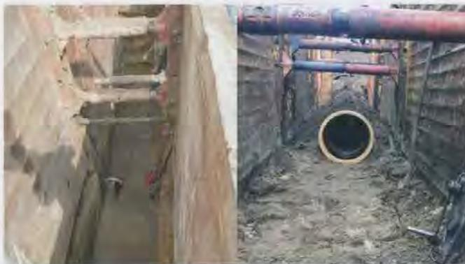
**Bild 1:** Unsachgemäß bzw. fachgerecht: Die extreme Abweichung zwischen Rohr- und Verbauachse macht eine fachgerechte Herstellung der Bettung und der Zwickelverdrichtung nicht möglich (!). Einbau des Rohres mit beidseitig gleichem Arbeitsraum gemäß Regelwerk (r.)
