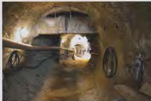
**Bild 2:** Der Stollen wird laut Planungen in gekrümmter Linienführung hergestellt. Eine kreuzende Abwasserleitung wird während der Baumaßnahme temporär abgelenkt und später an den fertigen Kanal angeschlossen
