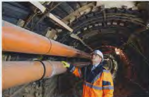
Prüfingenieur Marc Mielke überzeugt sich vor Ort von der fachgerechten Ausführung des Stahlverzuges.
