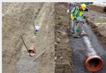
Bild 3 Angeschütteter, nicht verdichteter Bereich der Leitungszone und der Abdeckung (l.); Lagenweiser Einbau Verdichtung über die gesamte Grabenbreite (r).
