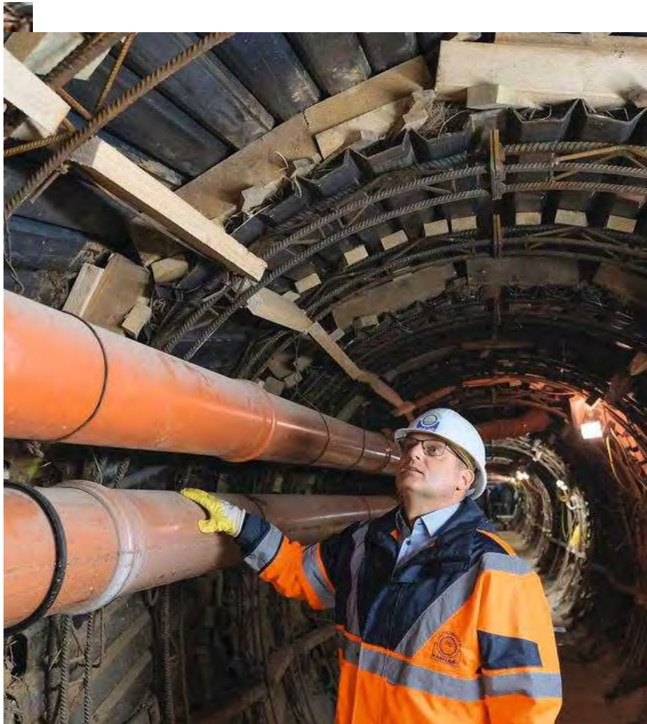
Prüfingenieur Marc Mielke überzeugt sich vor Ort von der fachgerechten Ausführung des Stahlverzuges. | Foto: Sabine Grothues
