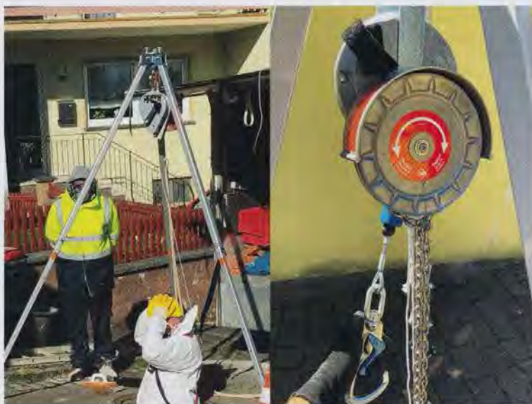
Bild 1. + 2. Nicht fachgerecht (l.): Der Anschlagpunkt ist nur für die Absturzsicherung geeignet, nicht für die Verwendung eines Höhensicherungsgerätes mit Kurbel zur Personenrettung. Fachgerecht (r.): Eine Rettungshub-Funktion hängt an einem geeigneten Anschlagpunkt ist nur mit Haspelkettenantrieb möglich.
