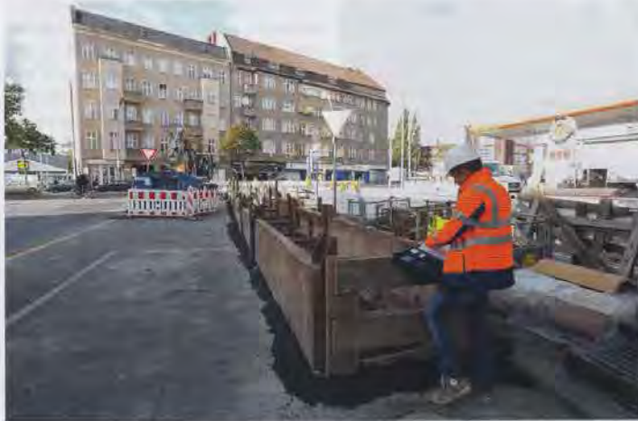
Stephan Tolkmitt gehört zu den Prüfsingenieuren, die in vorgegebenen Abständen die Baustellen der Gütezeichen führenden Unternehmen besuchen. | Fotos: Güteschutz Kanalbau
