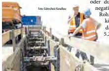
Foto: Gütegemeinschaft Kanalbau
